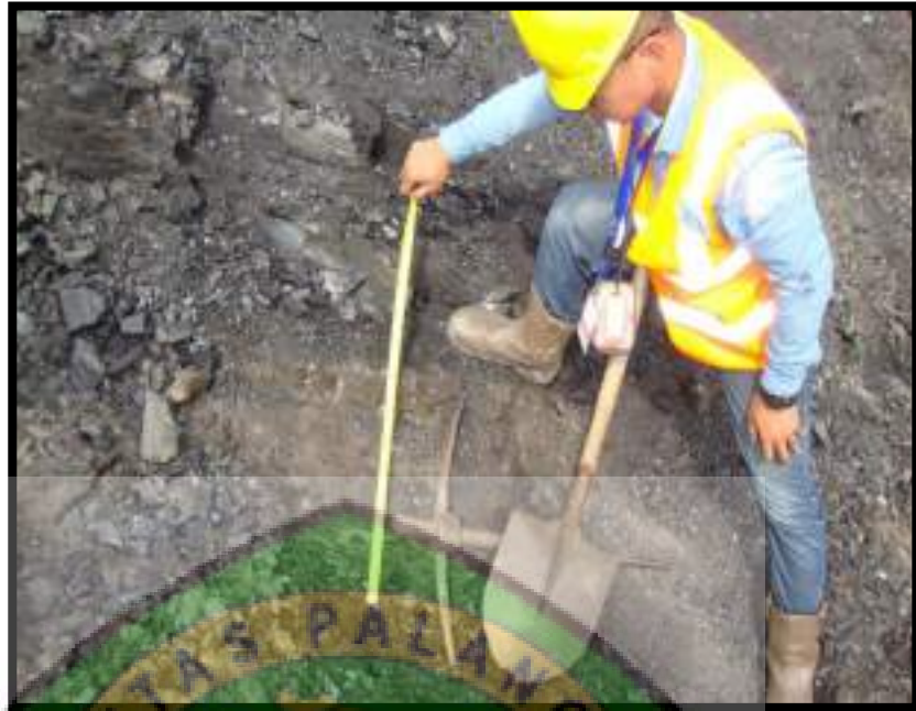
Gambar 4.18 Sisipan Claystone Pada Seam 15 Sumber: Dokumentasi Penelitian
